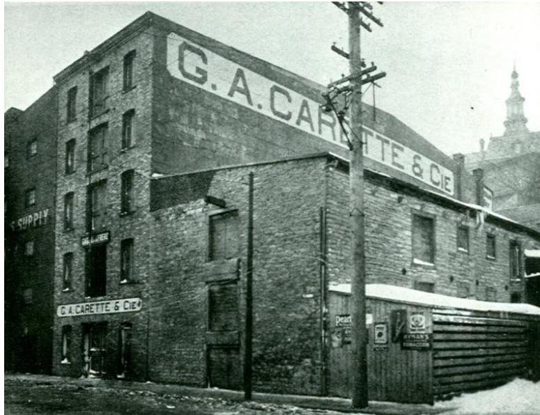
Vue du quai Saint-André, vers 1910, AVQ
