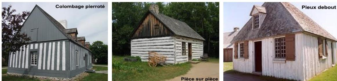
Le colombage pierroté demande peut-être une brève explication, les deux autres types de construction étant généralement connus. En colombage pierroté, on observe un espace entre les pièces de bois verticales, et cet espace est comblé par un mélange de pierres, d'argile ou de mortier, et de paille ou de crin de cheval. Voyez la [Maison Lamontagne](#) à Rimouski. Ces
