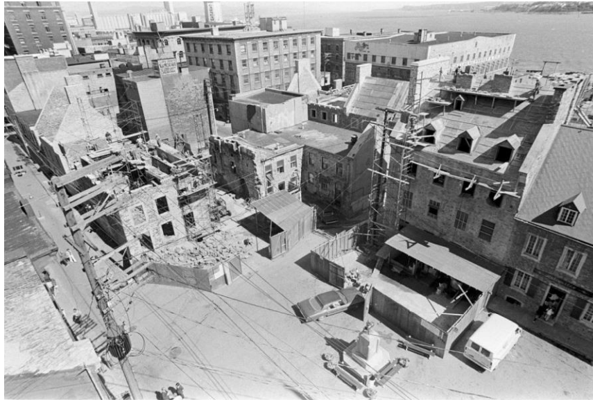
Années 1970 : démolition, restauration, reconstitution
